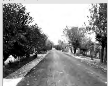
• дорожнього покриття по вул. Січових Стрільців. Площа асфальтування дороги – 1463 кв. м;
