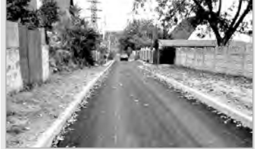
• дорожнього покриття по вул. Адмірала Ушакова. Площа асфальтування дороги складає 1846,9 кв. м;
