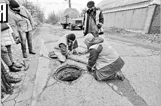
отверстие канализации спецткань, пропитанную цементной смесью. При намокании она, как гипс, становится твердой. В трубу, следом за цементными "тампонами", забили еще и деревянную заглушку.
