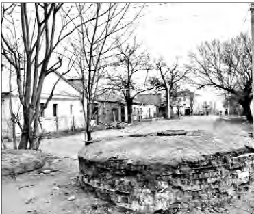
Остатки одного из водопроводных колодезев, с помощью насосов, вода поступала в башню Шухова
